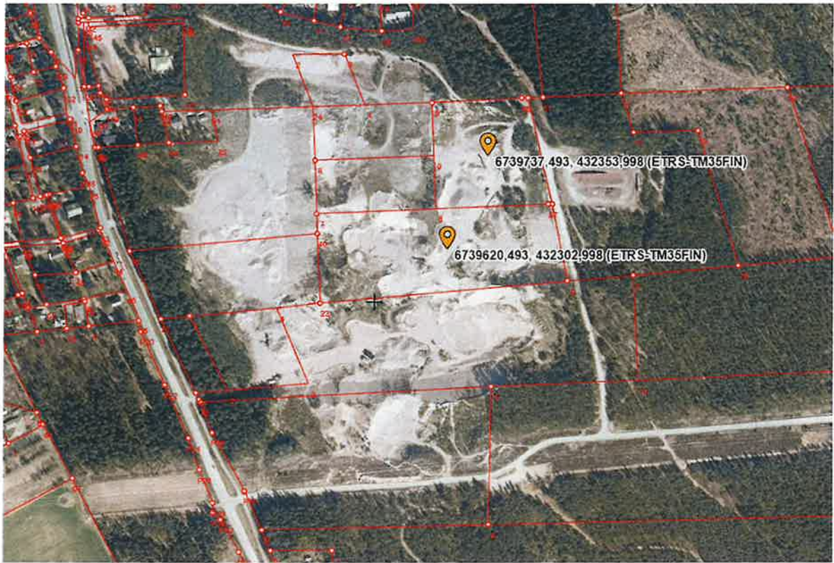
Kuva 3 Ilmakuva vuodelta 2025. Kohdekiinteistöjen keskipisteet merkitty kuvaan.
