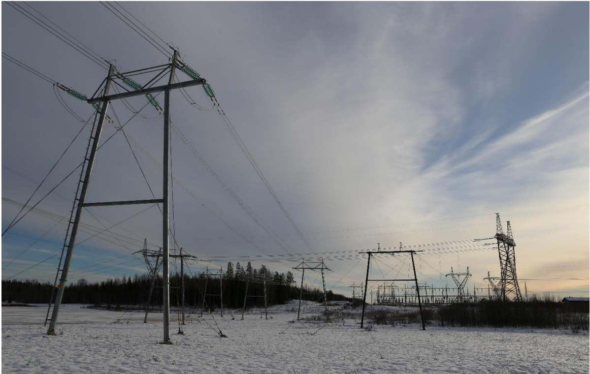
Kuva 4-24. Voimajohtomaisemaa suunnittelualueen kaakkoisosassa kuvattuna Rautamäentieltä kohti etelää ja Fingridin sähköasemaa.
