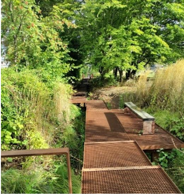
Kuva 18. Kävelyreitti puistoalueen läpi on toteutettu ojan päälle nykyistä kasvillisuutta mahdollisimman paljon säilyttäen ja kunnioittaen (AFRY Finland Oy)
