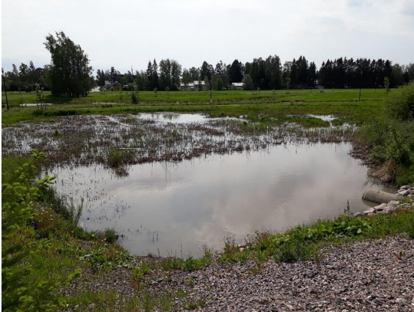
Kuva 20. Esimerkki yleiselle alueelle toteutetusta kosteikosta lumensulatusalueelta purkaville vesille (AFRY Finland Oy)
