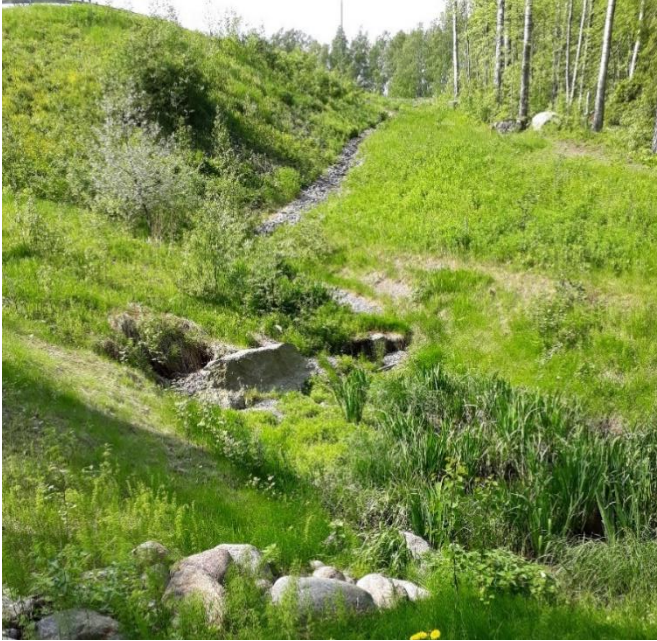
Kuva 21. Vaihteleva ja mutkitteleva avoin uoma, jossa on patokynnyksiä ja kasvillisuutta (AFRY Finland Oy)
