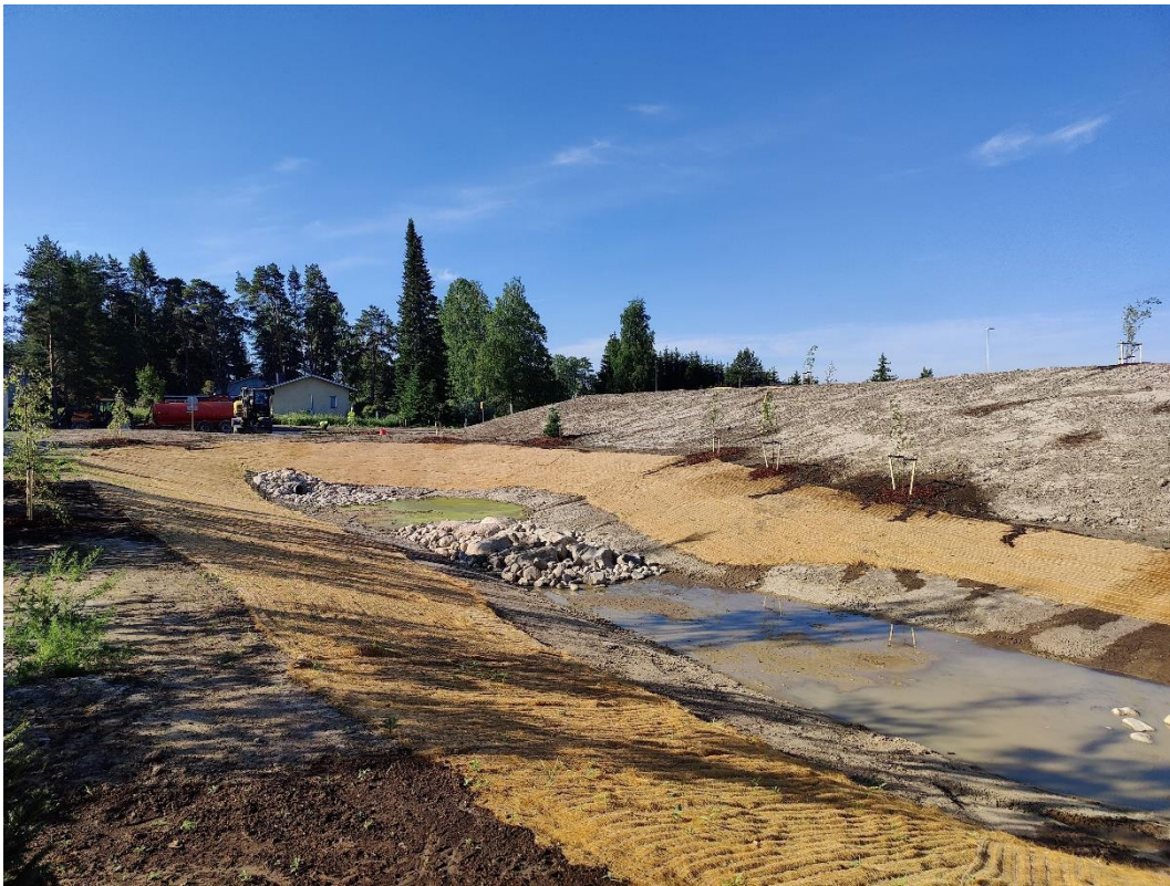
Kuva 6 Virenojan uuden asuinalueen hulevesialtaan pintarakenteet heinä-kuussa 2022 (lähde: Orimattilan kaupunki)
