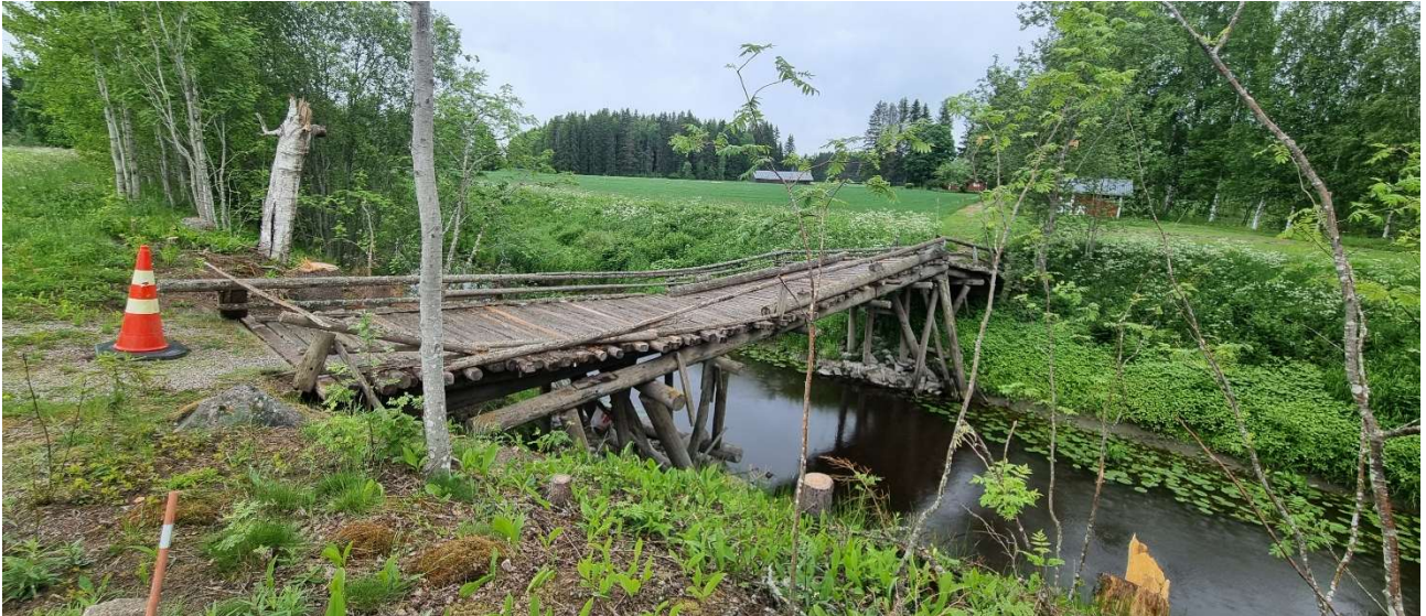
Kuva 4. Hankealueen pohjoispuolella on vanha puinen silta. Luoteeseen.
