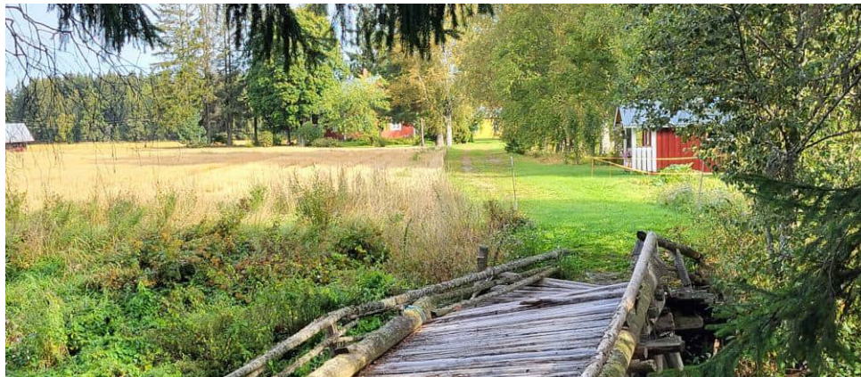
Kuva 21 Jokilahden pihapiiri romahtaneen sillan takaa.
