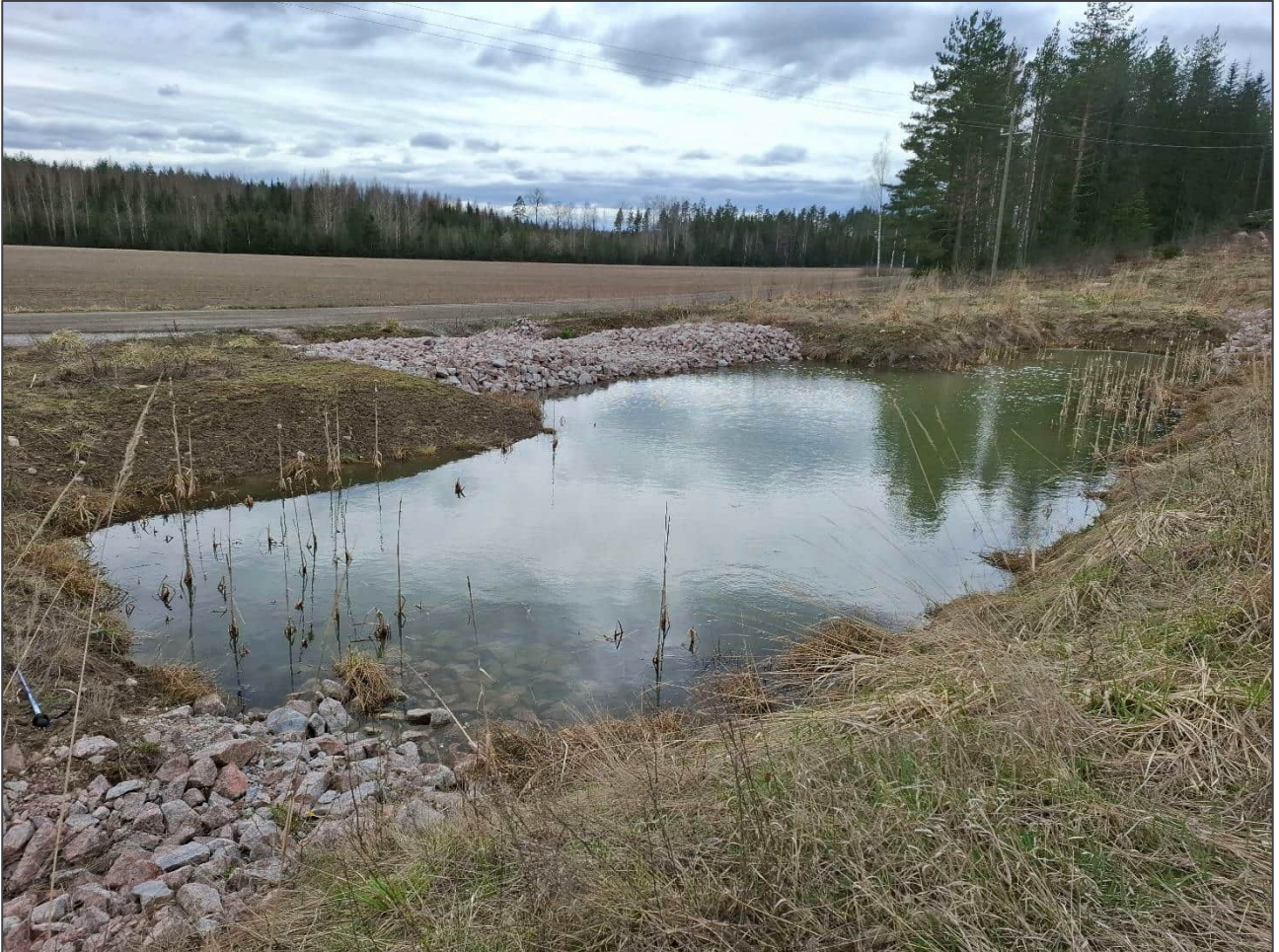
Kuva 6-3. Mäyrämäen maanvastaanottoaikan eteläpuolella, Rautamäentien vieressä oleva rakennettu laskeutusallas, jossa havaittiin sammakonkuttua.
