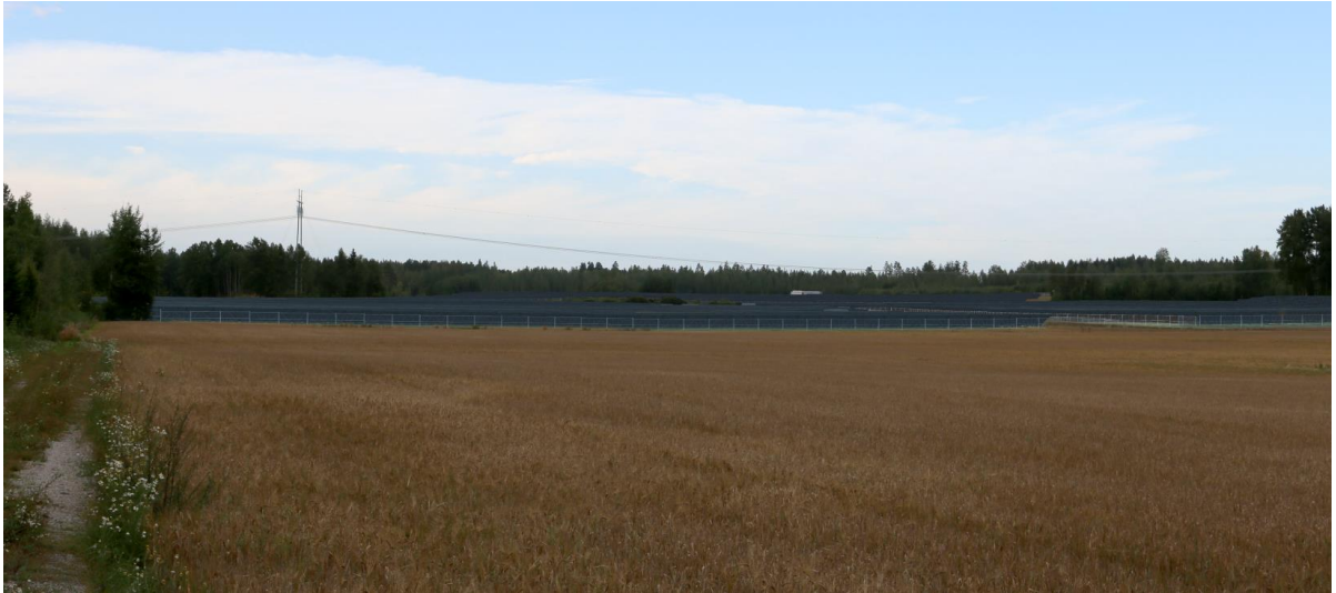
Kuva 7-4. Havainnekuva Knaapinmäeltä (Loukkaanmäen länsilaidalta) kohti Rengonjokilaaksoa etelään suuntaan (kuvauspaikka 8). Paneelialueiden keskellä kulkee Fingridin 110 kV voimajohto Korja–Orimattila. Paneelikenttien takana näkyy Lahdentiellä kulkeva vaalea rekka-auto. Kuvauspisteestä on noin 250 m etäisyys lähimmille aurinkopaneeleille ja Lahdentielle noin 1,3 km etäisyys.
