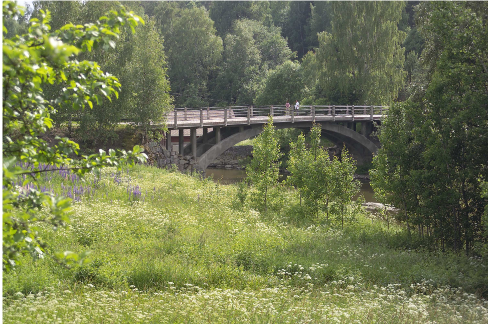
Tönnön silta, joka kulkee Porvoonjoen yli Tönnönkosken kohdalla, on suojeltu museosilta.
