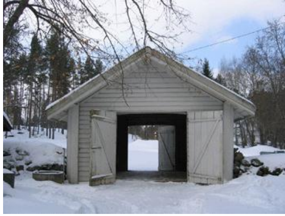
Läpikäytävä (Teija Ahola)
