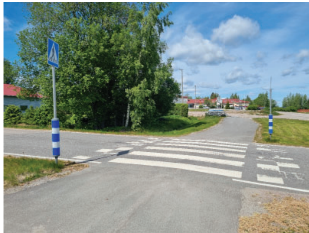
Kuva. Kevytliikenteen tie Uotilanrinteen uudelta asuntoalueelta koululle, suojatiet Lankilantien yli.
