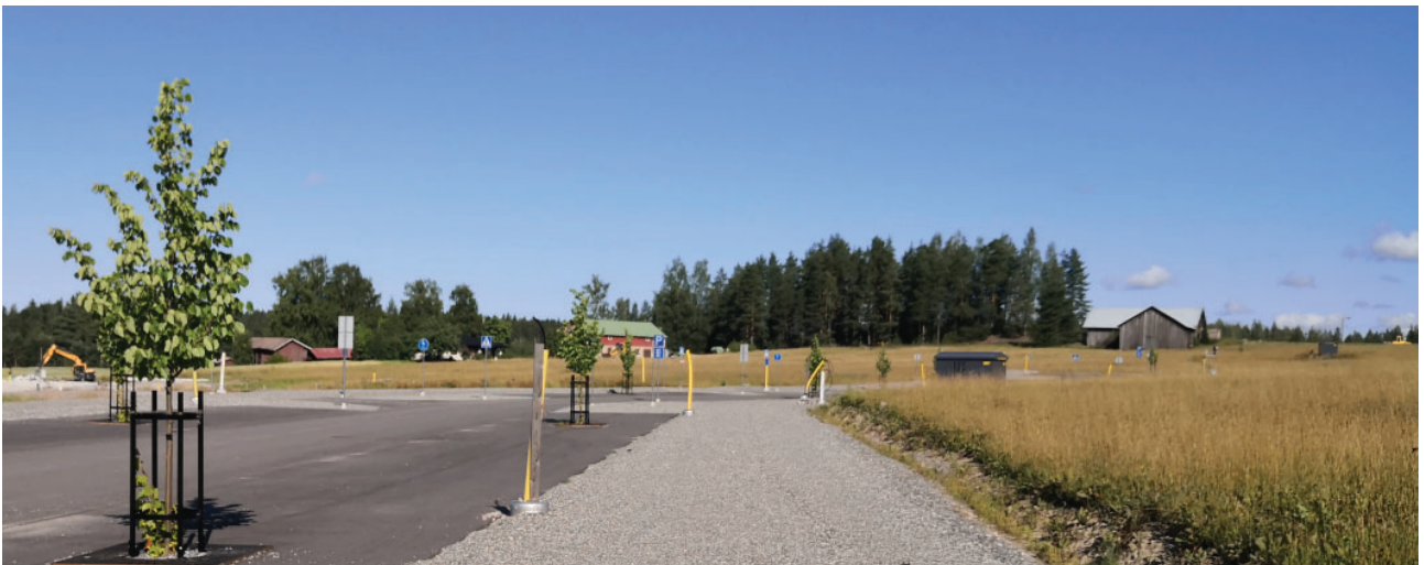
Kuva. Näkymä rakenteilla olevalta Sahramikadulta kaavamuutosalueelle
