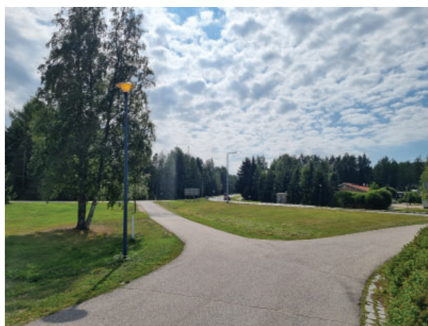
Hyväkuntoinen jalankulku- ja pyöräilyväylä Helsingintien pohjoispäässä.
