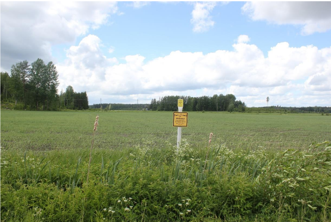
Kuva 19. Maakaasun runkojohto ei näy maisemassa. Kuva FCG/Ida Tammi 2024.
